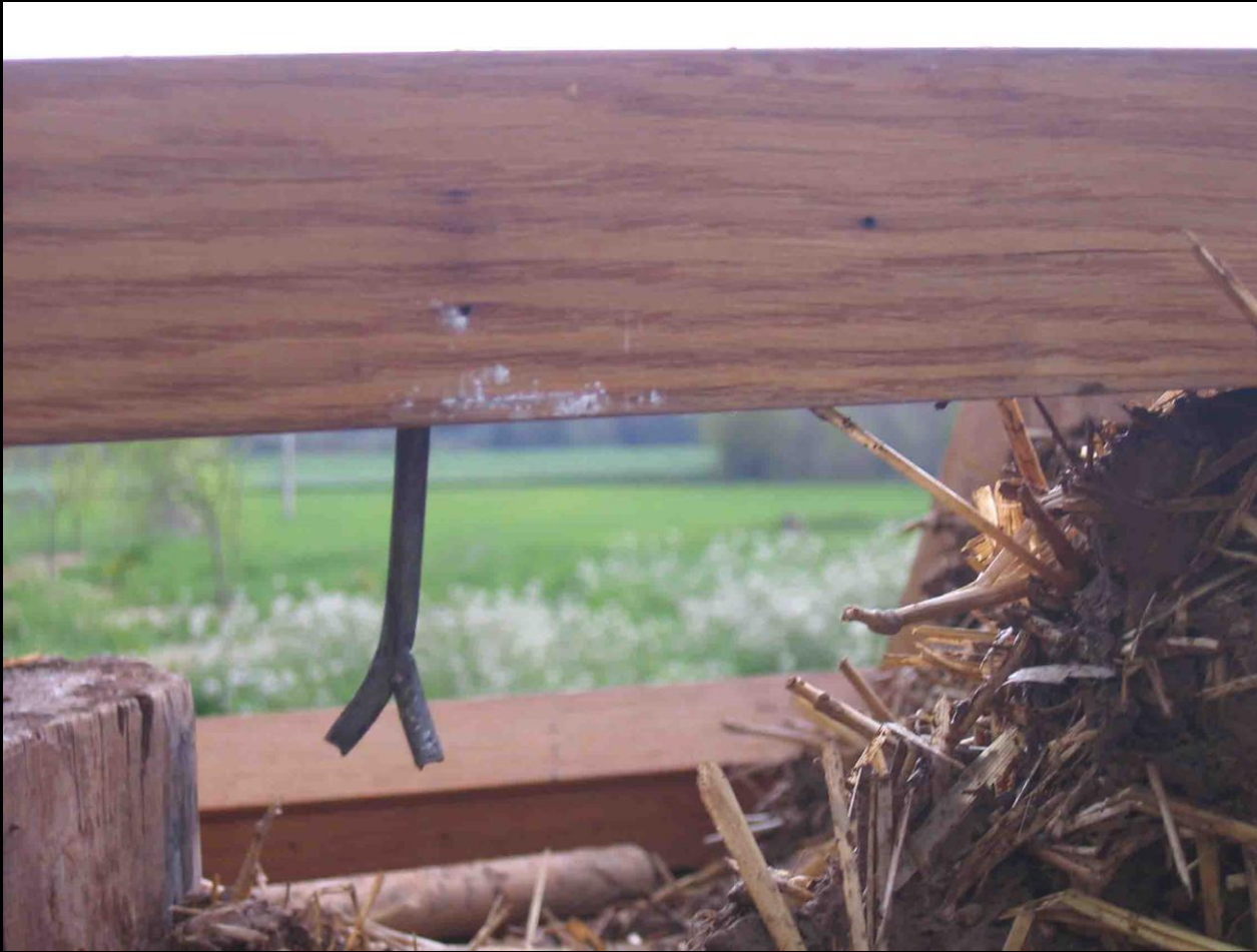
7. Detail de l'ancrage
